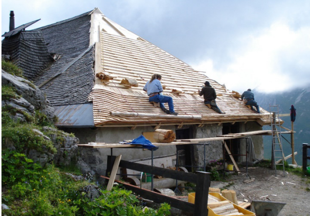
Chalet du Pralet, les tavillonners au travail sur un grand toit © Association Romande des Tavillonners
