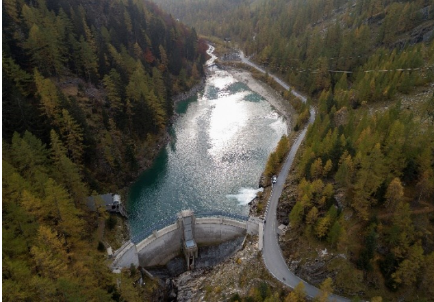
Barrage de Serra, prise de vue drone, Zwischbergental, octobre 2019 © Thomas Andenmatten Fotograf Brig
