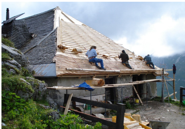
Alphütte Le Pralet, Schindelmacher bei der Arbeit an einem grossen Dach © Association Romande des Tavillonneurs
